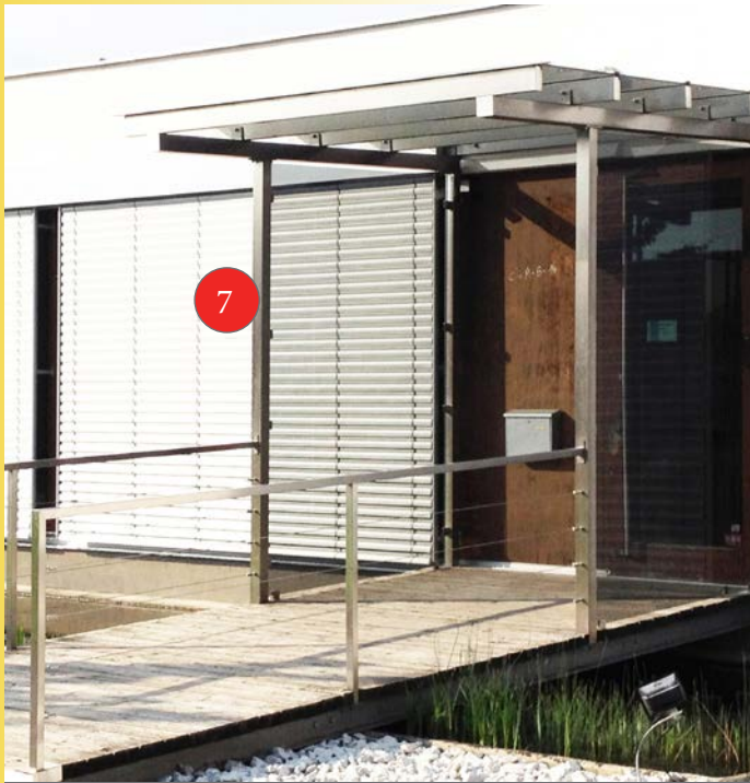
Bild Nr. 700, Vordach mit Windfang
